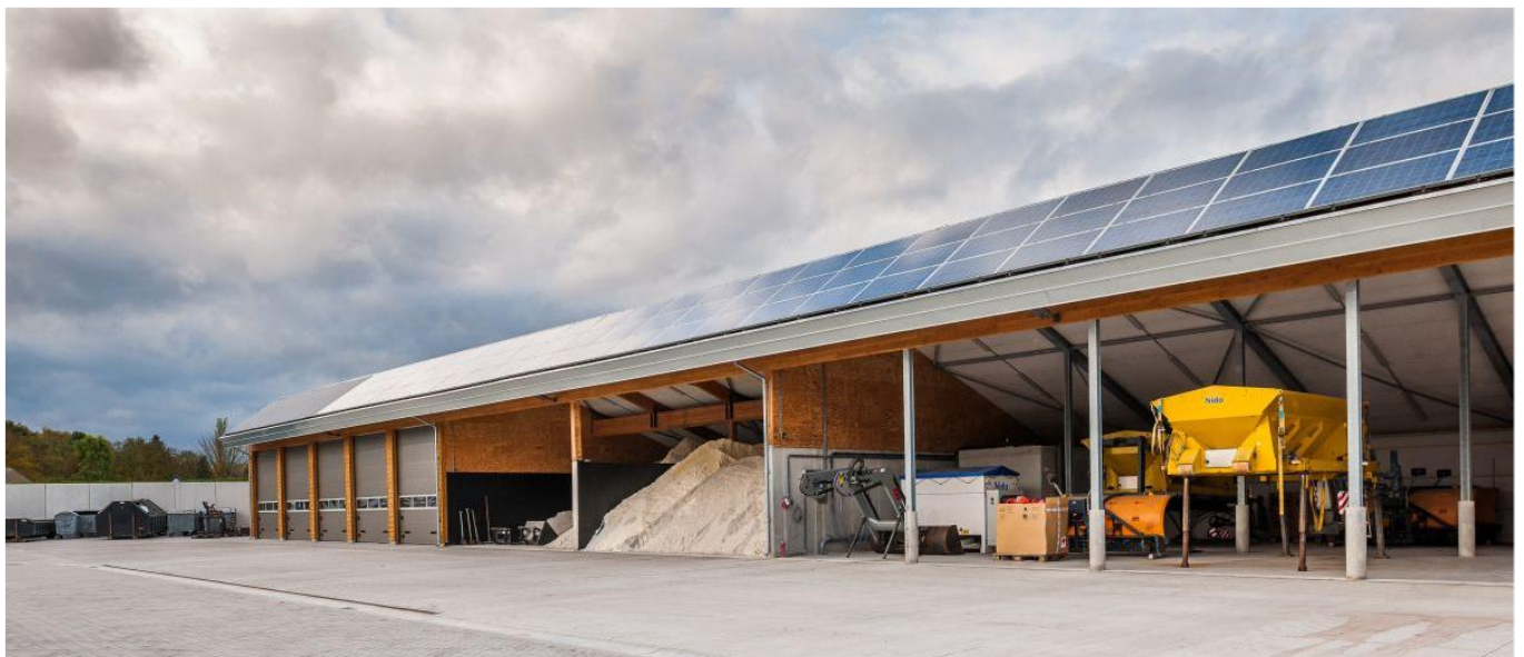
Het hele complex is volledig voorzien van duurzame stroom door zonnepanelen
