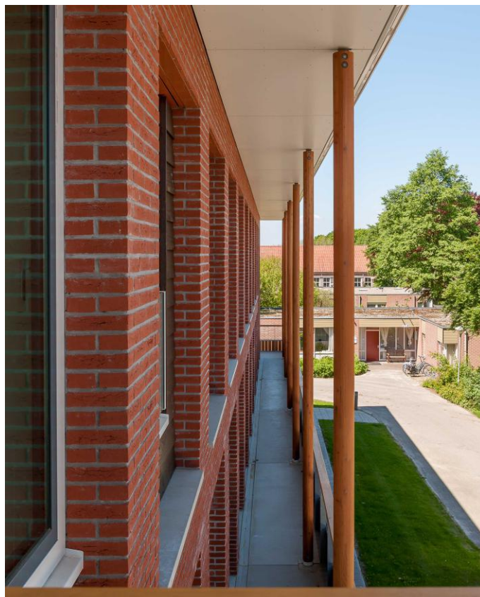
Dubbele gevel; geborgenheid, ontsluiting, buitenruimte en zonwering
